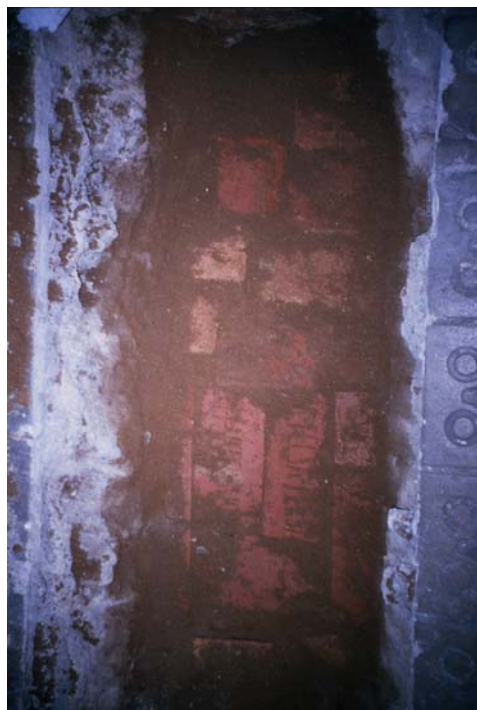
Fotografia 4: Niveau de tuiles rouges UE 301.
