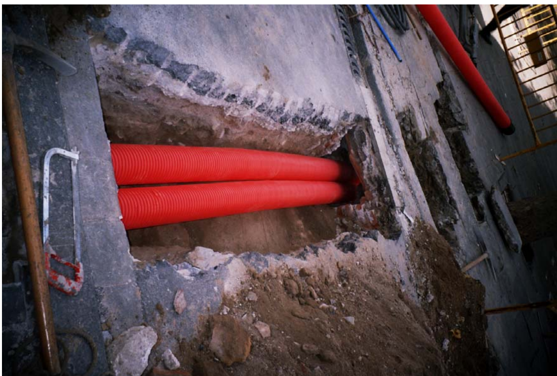
Fotografia 16: Col·locació dels tubs per sobre U. E. 702.
