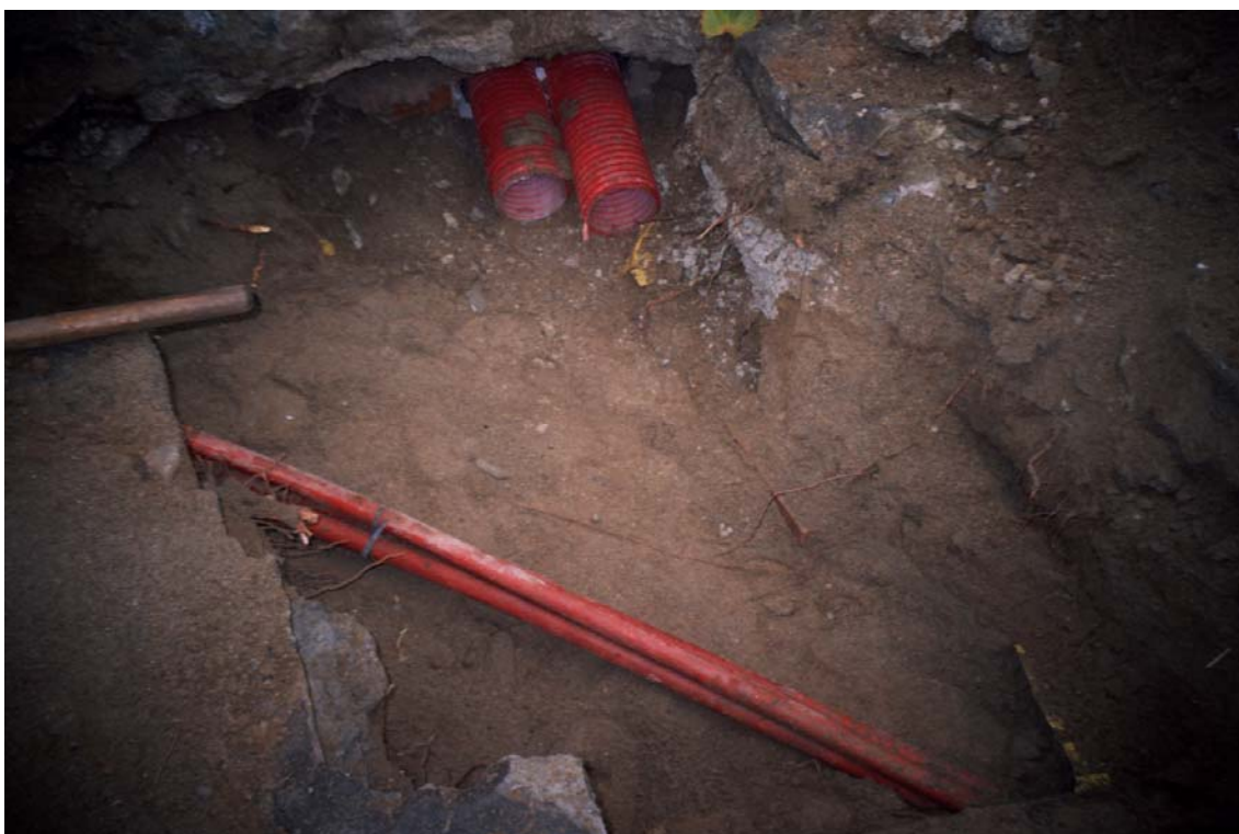
Fotografia 17: Zona de connexió entre els cables de la plaça Canonge Colom i els del carrer Junta de Comerç.
