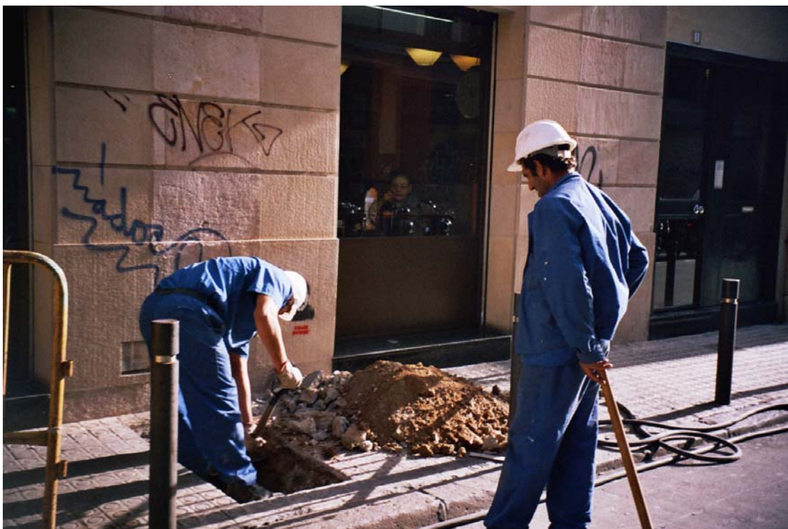
Fotografia 1: Inici de l'excavació al carrer Junta de Comerç.
