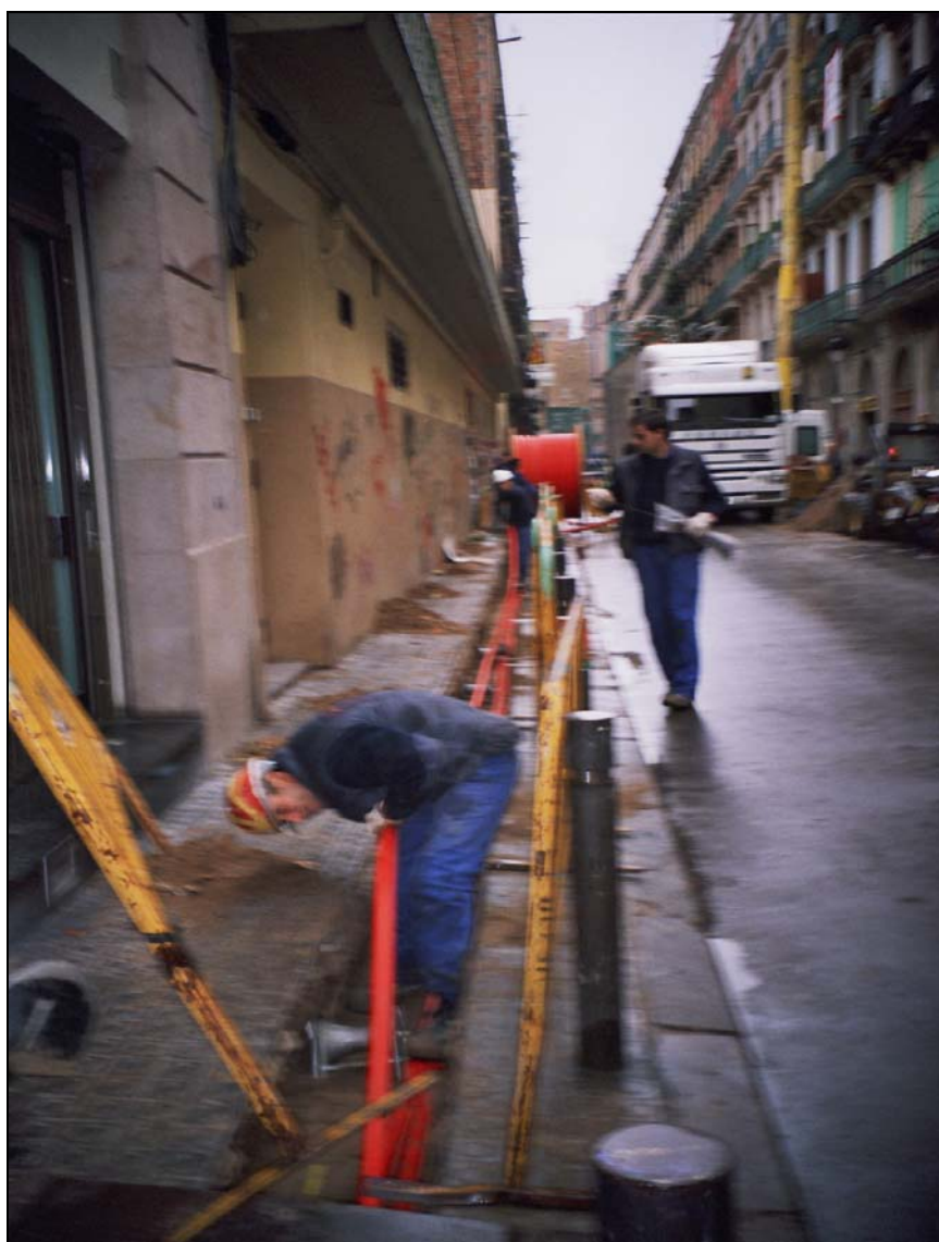
Fotografia 18: Col·locació dels cables de mitja tensió.
